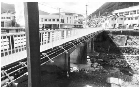
川底が橋脚の一部を削り取り、今では橋の沈下で落橋の恐れもあるため通行止めとなっている。新橋梁の規模は現橋と同程度で、片側に歩道を設置する。構造については
